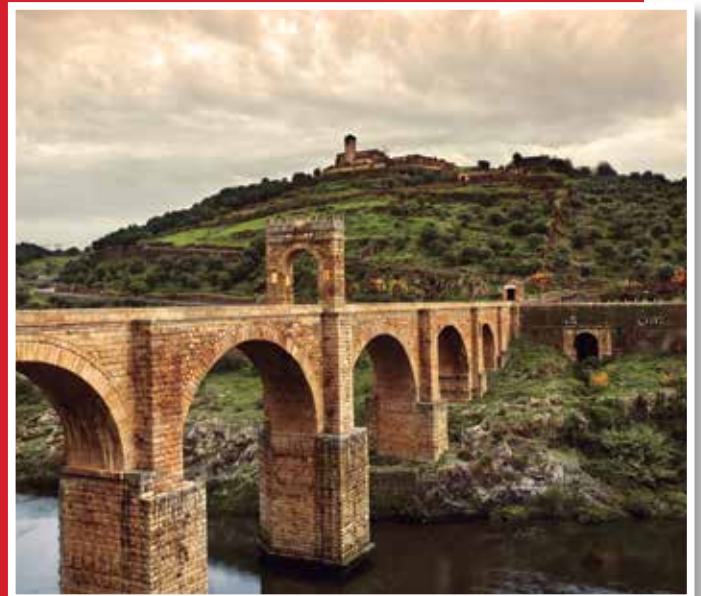
El arco de Trajano sobre el puente de Alcántara. The Trajano Arch on the Alcántara Bridge.
